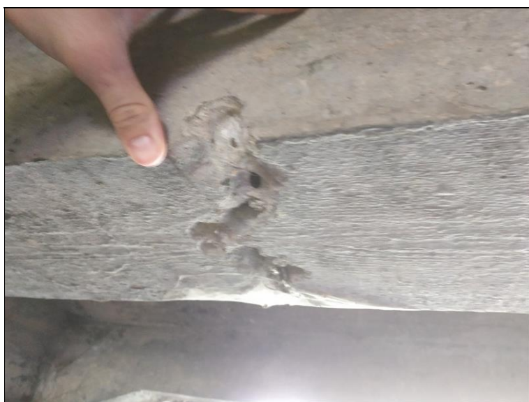
Lokální degradace betonu na původní trámové ŽB konstrukci.
