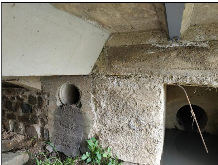
Degradace betonu rozšíření opěr, vápenné výluhy.
