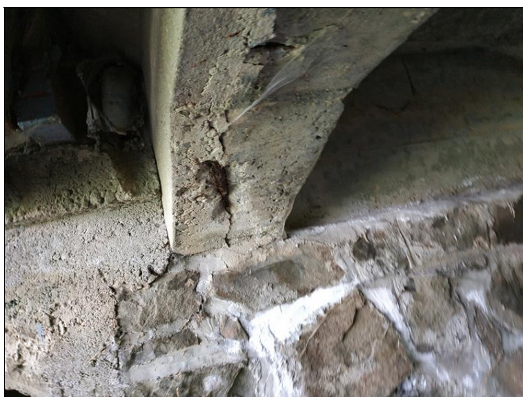
Obnažená korodující výztuž a degradace betonu na krajním levém trámu u OP2.
