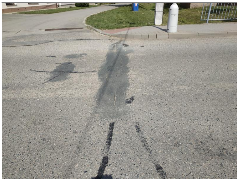
Příčná trhlina ve vozovce v předmostí OP1.
