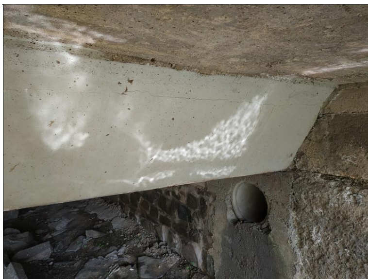
Podélné trhliny s výluhy v obetonování krajního pravého nosníku.
