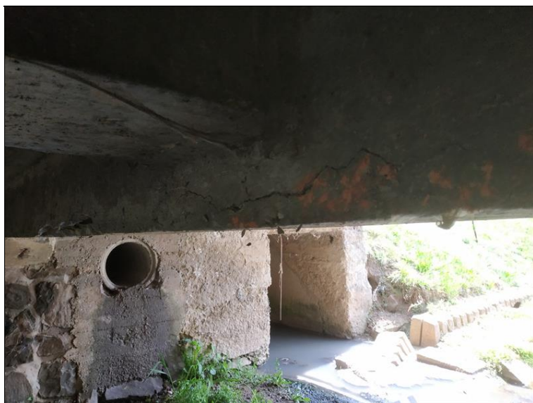
Obnažená korodující výztuž a podélná trhлина na krajním pravém trámu..
