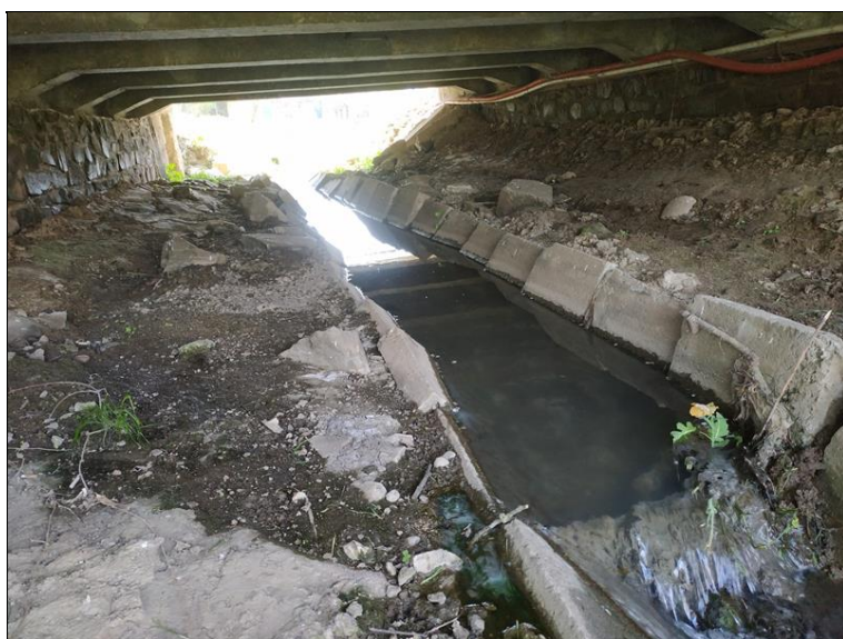
Betonové tvárnice tvořící koryto vodního toku jsou rozvolněné a nelicují.
