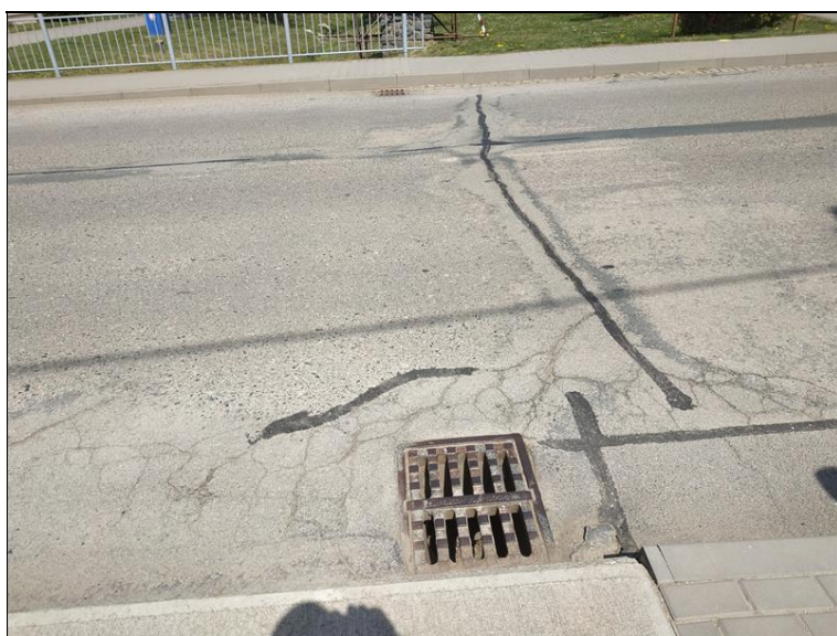
Příčná trhlina ve vozovce v předmostí OP2. Sítové trhliny v okolí kanalizační vpusti.
