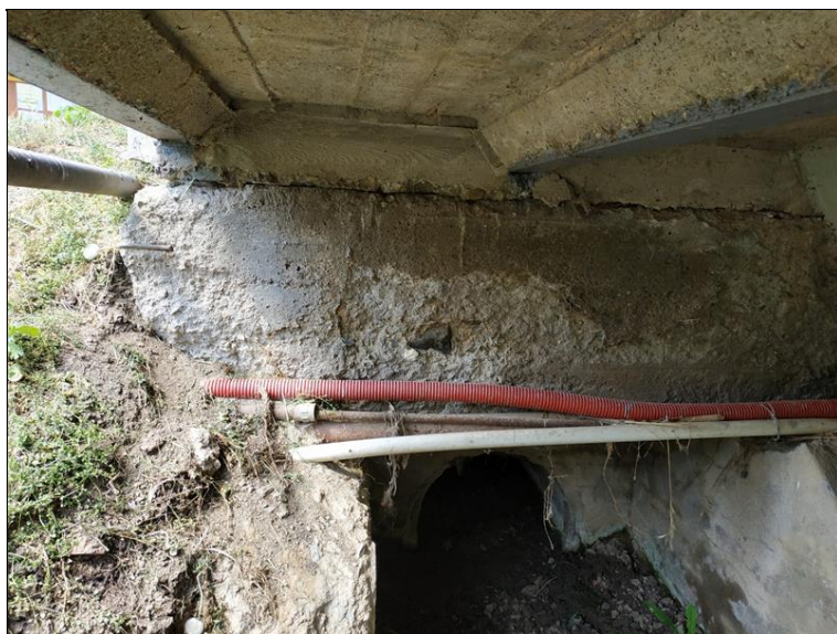
Degradace betonu rozšíření opěr, vápenné výluhy.
