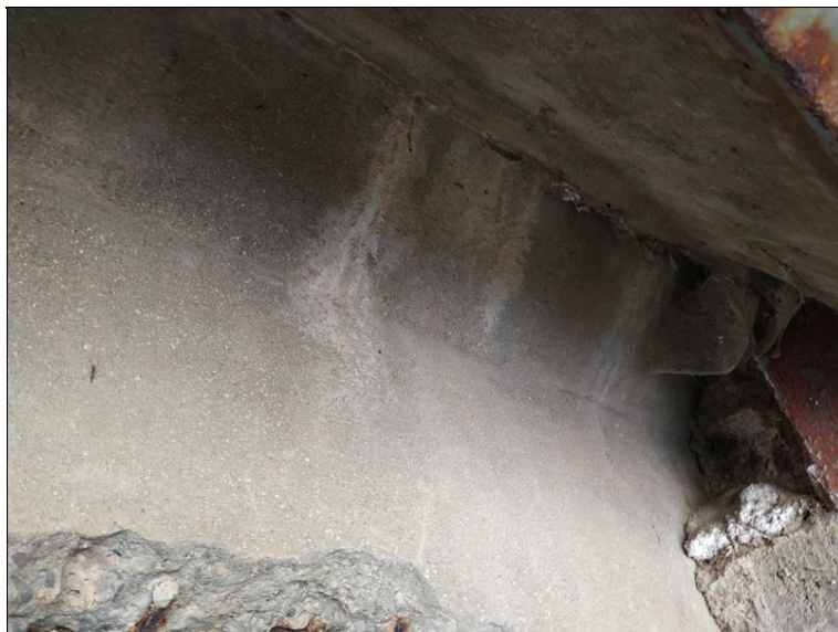
Stopy po zatékání na rozhraní původní konstrukce a rozšíření.
