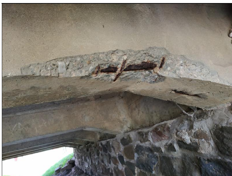
Obnažená korodující výztuž na krajním pravém trámu u OP2.
