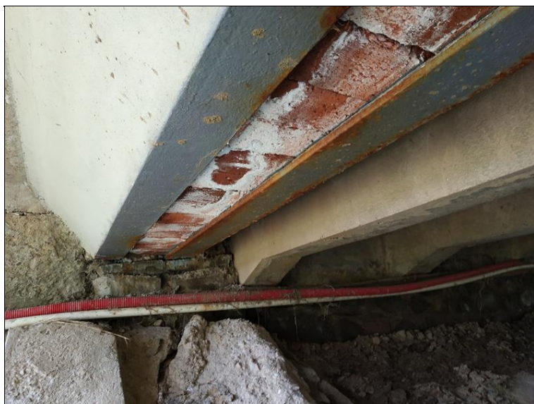
Vápenné výluhy na cihelné vyzdívce, koroze pásnic I-profilů vpravo.
