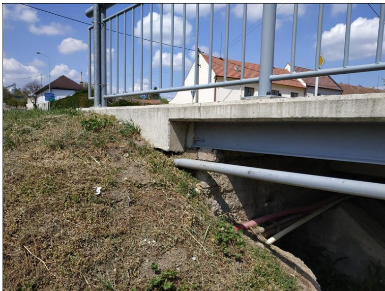
Pravé rozšíření opěry u OP1.
